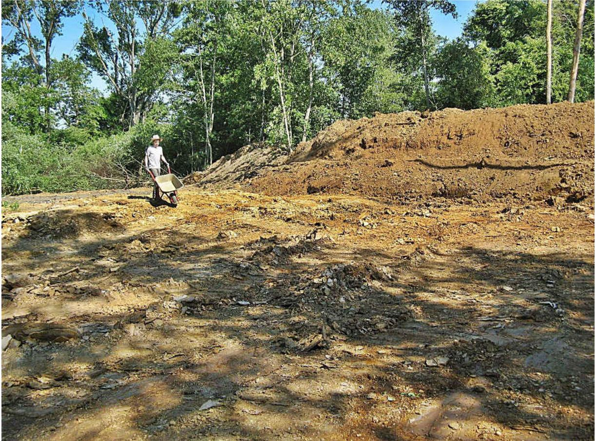
Manuelle Freilegung, Einebnung und Reinigung des Schieferhorizontes auf der neuen Erweiterungsfläche.
